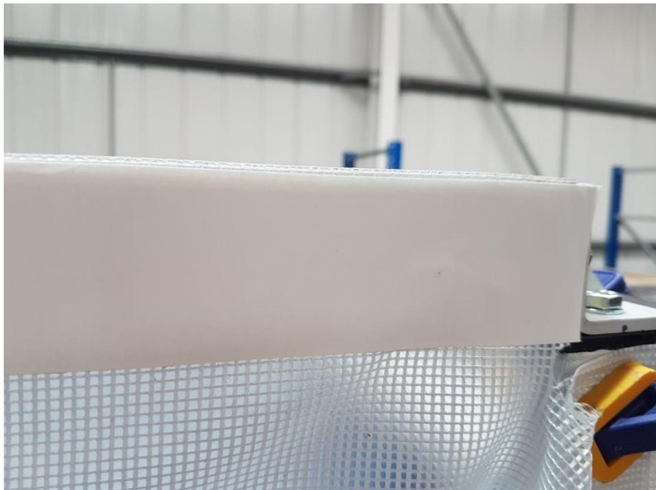
25) Déballez le capot avant enroulable et maintenez-le en position. Retirez le dos de la bande adhésive double-face et collez-la soigneusement en commençant par les coins du haut, et en vous assurant que le haut est de niveau et est à fleur du bord des poteaux. Une fois que les deux coins sont fixés, retirez le reste du dos de la bande adhésive et collez toutes les surfaces, vous assurant qu'elles soient bien tendues pour qu'il n'y ait pas de pli.
