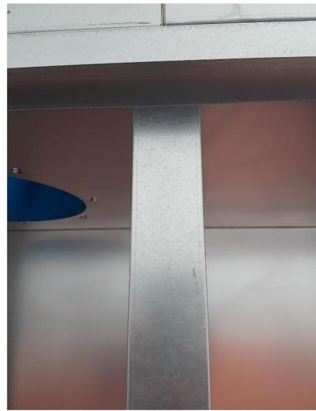
10) Positionnez le cadre de la porte d'accès et fixez-le avec des vis tech (4,8x16mm).
