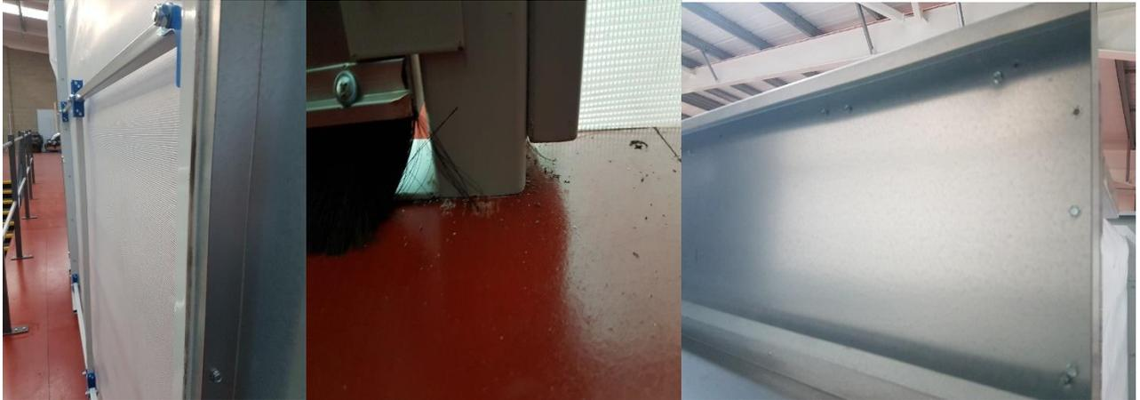
22) Lorsque le module est fixé sur l'extracteur, le PVC du rail de toit avant peut être collé en place de la même manière qu'auparavant, en commençant à chaque extrémité, en le positionnant de niveau avec la fiche arrière et le haut du rail.
