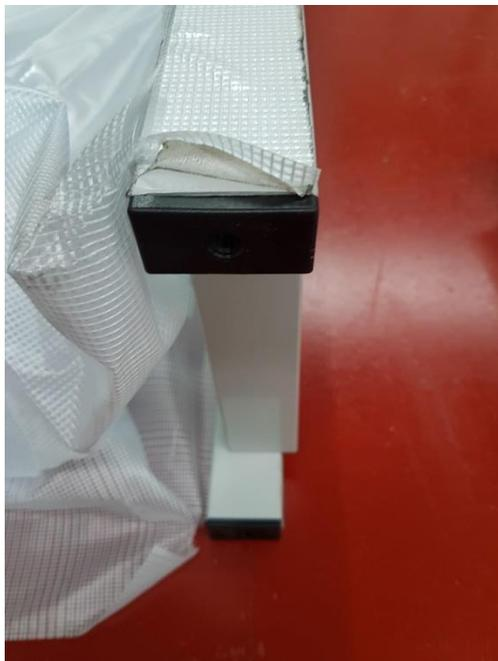
18) Positionnez le rail de toit prêt à être fixé sur le poteau avec les pattes en L et des boulons M8 20mm et rondelles. Commencez par le rail de toit avant, le côté avec la bande adhésive vers le bas, le bord du raccord d'angle avec les vis tech est le haut du rail. Lorsque vous l'avez positionné, assemblez le rail de toit suivant, cette fois-ci avec la bande adhésive vers le haut, assurez-vous à nouveau que le bord supérieur du raccord d'angle soit bien la face avec les vis tech.
