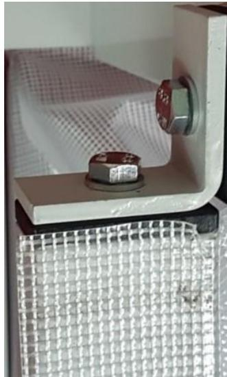
19) Lorsque les deux rails supérieurs sont fixés aux poteaux, alors, en faisant un côté à la fois, écartez suffisamment les cadres et fixez les équerres avec les vis tech (4,8mmx16mm) sur le rail et poteau supérieur. Vous devez vous assurer que les cadres sont à l'équerre. Idem de l'autre côté mais seulement le rail et poteau supérieurs face au sol.
