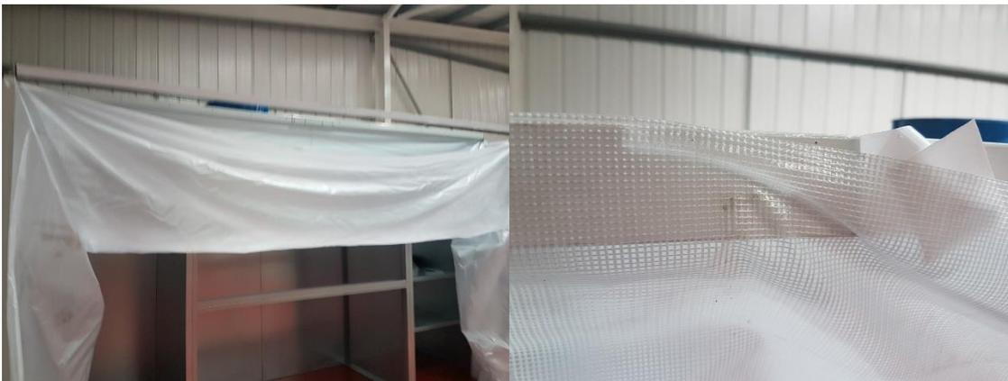
23) Les deux modules suivants montés comme de 16 à 20 et positionnés et fixés au module précédent au moyen des boulons M6, des rondelles et des écrous de sécurité nylon pour tenir ensemble. Il vous faudra auparavant percer au travers des trous pilotes pour pénétrer à travers la feuille de PVC ou utiliser un outil pointu.
