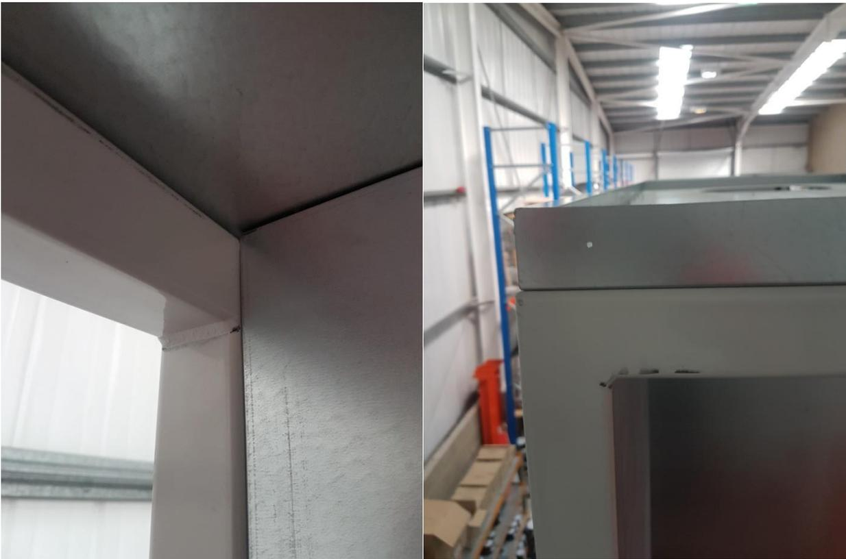
11) Montez la porte. Fixez le panneau plein au cadre au moyen des vis auto-perforantes à tête pan (4,8x16mm). Fixez ensuite le bord de porte au moyen des vis tech (4,8x16mm) ainsi que les charnières au moyen des vis tech (4,8x16mm) et fixez le tout au cadre.
